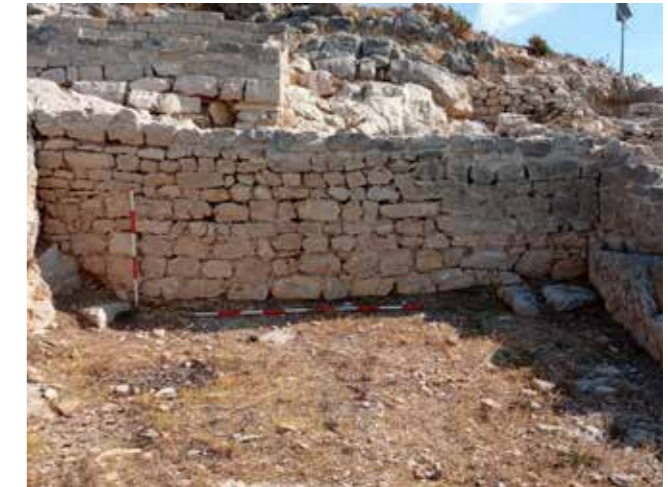
Sl. 13. Rimskodobni zid u tehnici opus quadratum | Fig. 13. Roman-era wall in the opus quadratum technique
