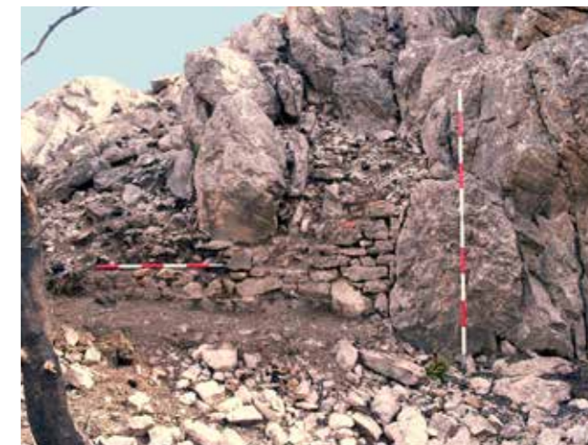
Sl. 22. Zid prostorije 21 | Fig. 22. Wall of Room 21
